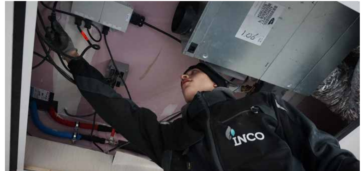
De Easyclickpro schakelaars en ontvangers zijn door een assemblagepartner geassembleerd en geprogrammeerd in handige hotelkamerboxen met stekerverbindingen, die plug-and-play in de hotelkamers geïnstalleerd konden worden.
